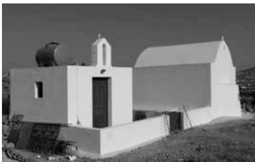
Εικ. 7. Βοηθητικό χώρο ναού Αγίου Γεωργίου.
