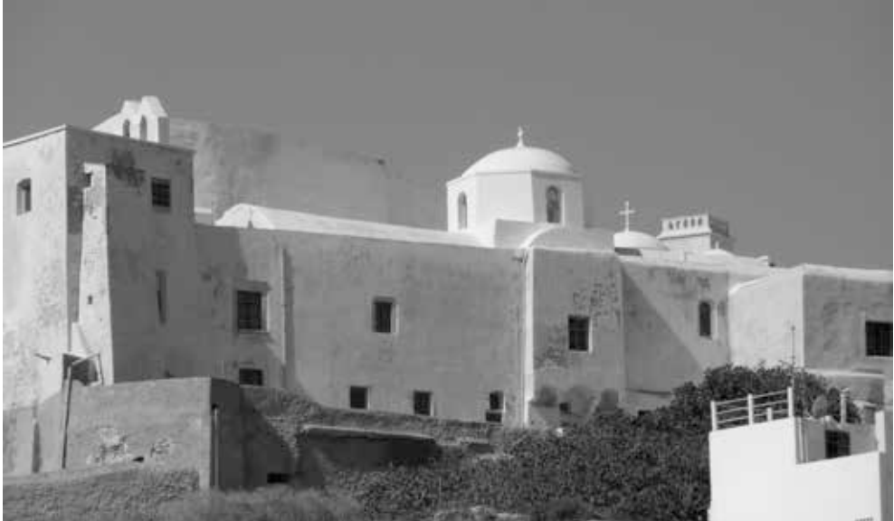
Εικ. 3: Το καθολικό της μονής των Φραγκισκανών Καπουκίων στο Κάστρο της Χώρας (17ος αι.).
