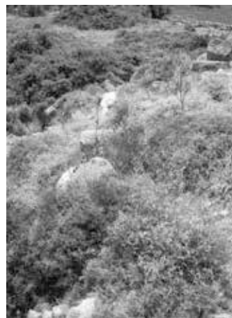
Εικ. 10: Δυτικός τοίχος του πύργου της Πλάκας, άποψη από Β
