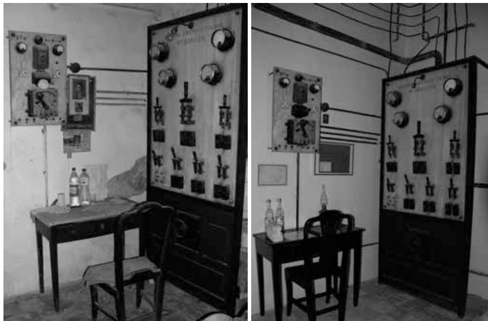
Εικ. 10 Εσωτερική άποψη του ελαιτριβείου πριν το έργο αποκατάστασης. ©Αρχείο Θ. Μπιλή – Μ. Μαγνήσαλη.
