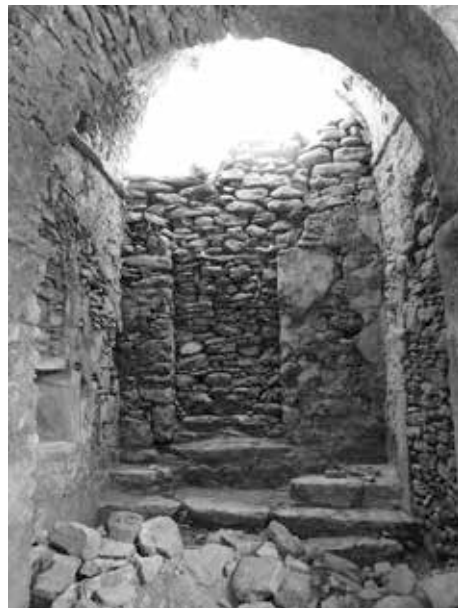
Εικ. 16: Θύρα εισόδου στο κεντρικό κλίτος.
