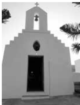
Εικ. 4. Το εξωκκλήσι του ναού του αγίου Γεωργίου. Νεότεροι φεγγίτες.
