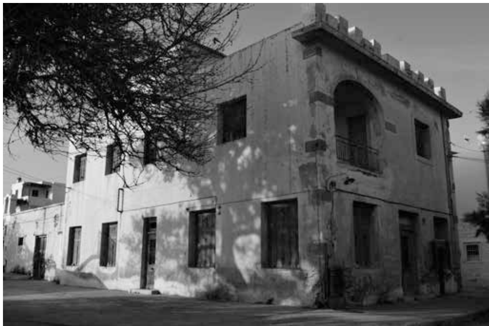
Κτίριο Διεύθυνσης, Μουσουάνα (φωτ.: Χρήστος Χρυσανθόπουλος).
