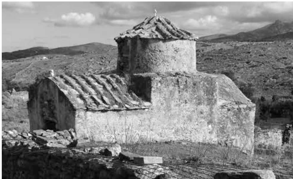
Εικ. 5: Διάταξη κεράμων στον τρούλο του ναού της Παναγίας Ορφανής.
