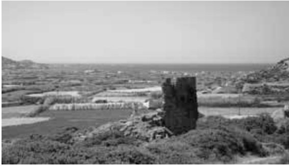
Εικ. 7: Συνολική άποψη του πύργου της Πλάκας, άποψη από ΒΑ.
