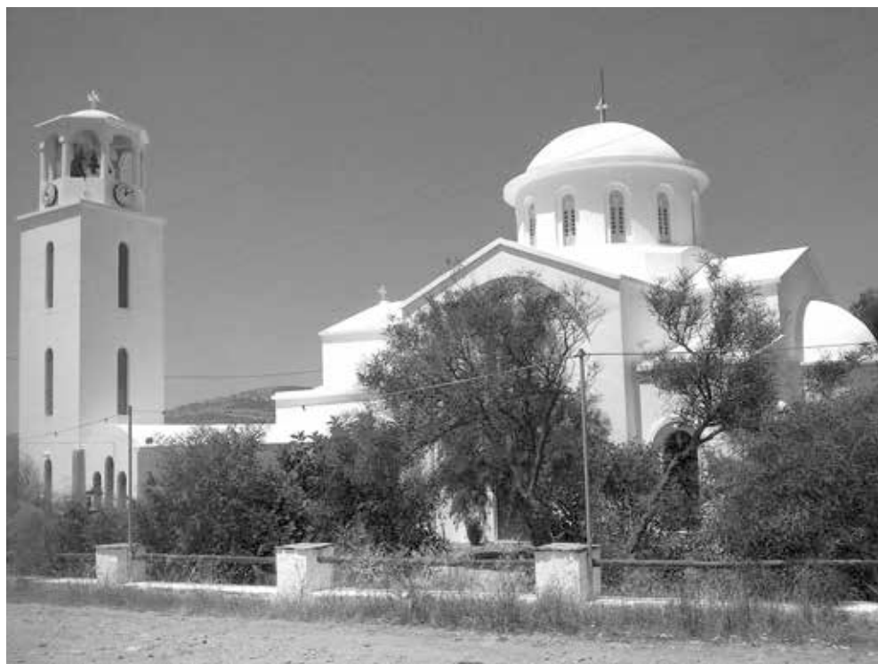
Εικ.2. Μονή Ταξιαρχών Νάξου. Άποψη της υφιστάμενης εκκλησίας των Ταξιαρχών.
