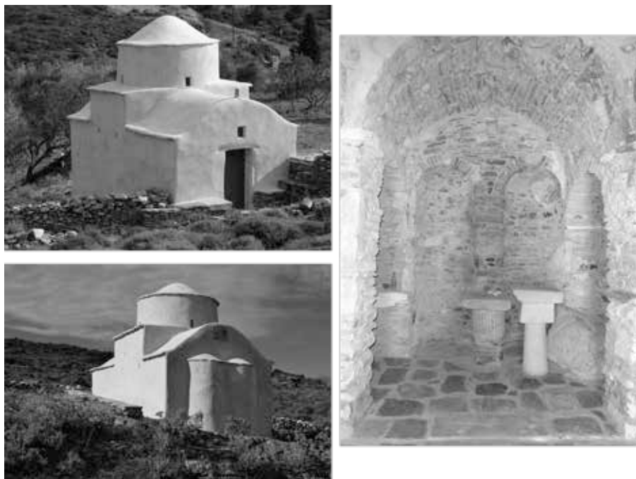
Εικ. 11: Ο ναός της Παναγίας Ορφανής, μετά την ολοκλήρωση των εργασιών αποκατάστασης των λιθοδομών και την εφαρμογή νέων επιχρισμάτων.
