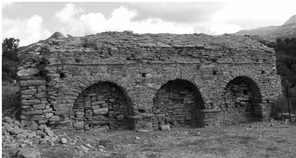
Εικ. 22: Νότια όψη ναού. Κατασκευή νέας τοιχοποιίας κατά μήκος της νότιας πλευράς του κεντρικού κλίτους.
