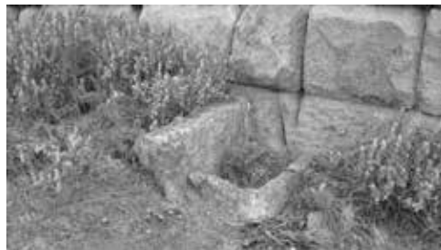
Εικ. 14: Η μικρή δεξαμενή για το πότισμα των ζώων στο εξωτερικό μέτωπο του Β τοίχου του Πύργου της Πλάκας.
